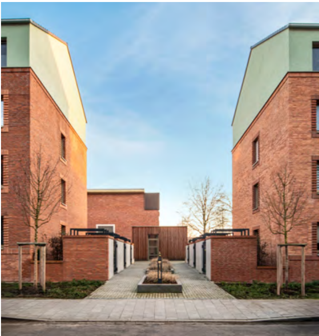
Sorgfältig in die Außenanlagen integrierte Müllabstellplätze am Durchgang von der Hagener Straße.
