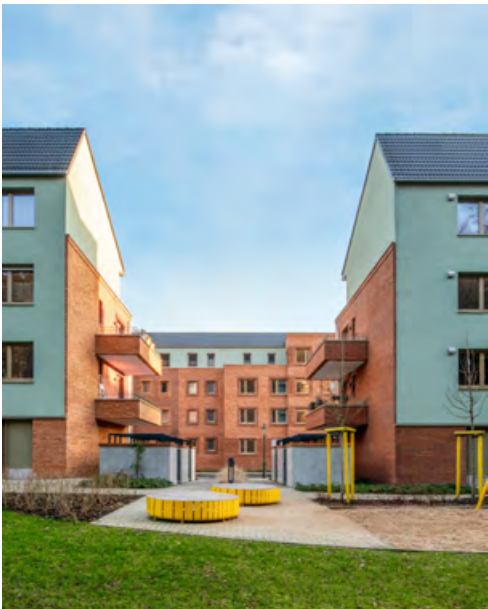
Durchgang zur Hagener Straße von Norden: Straßen- und Hoffassaden werden mit unterschiedlichen Klinker- und Putzstrukturen differenziert gestaltet.
