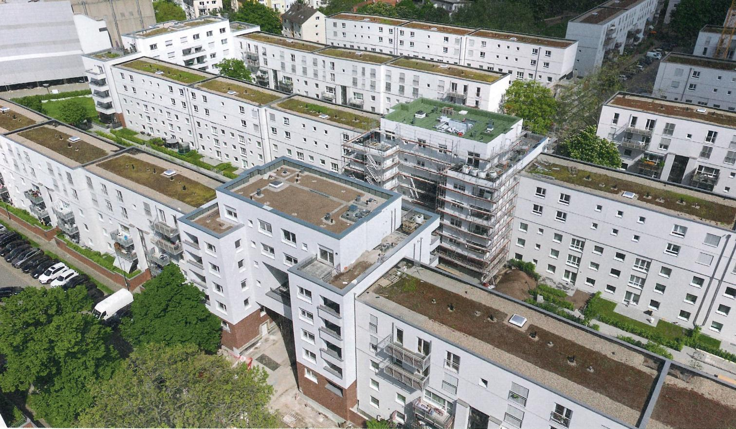
**Platensiedlung in Frankfurt am Main:** Die 19 Riegelbauten der in den 1960er-Jahren errichteten Anlage wurden um zwei Geschosse mit Holzmodulen (LiWood) aufgestockt und die Gebäude insgesamt weiß verputzt.
