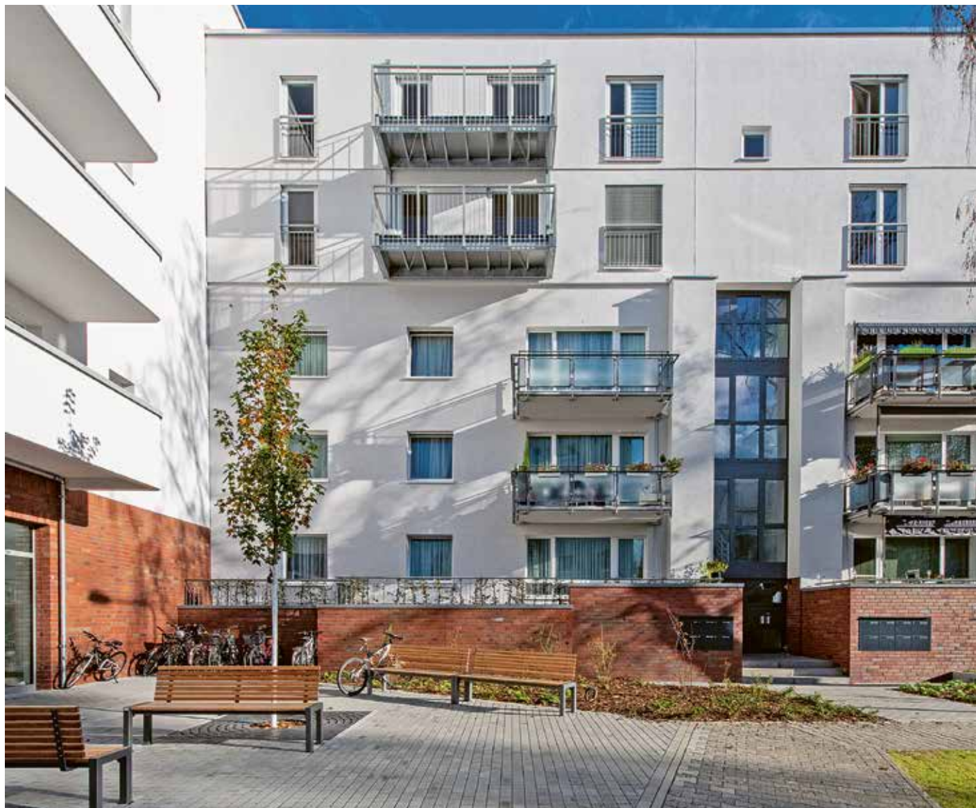
Stefan Forster Architekten, Umbau Platensiedlung, Frankfurt / Main, seit 2018, Foto: Lisa Farkas
