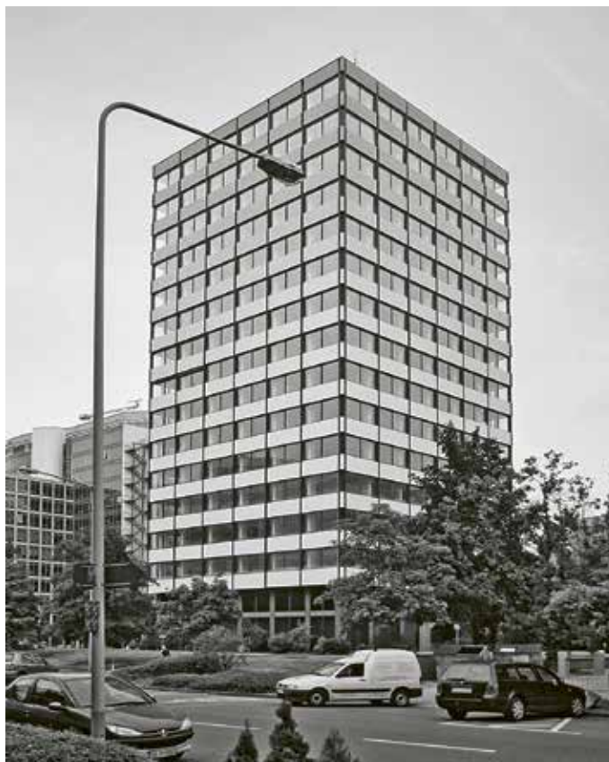
Bestandsgebäude Lyoner Straße 01 vor dem Umbau, Foto: Stefan Forster Architekten
