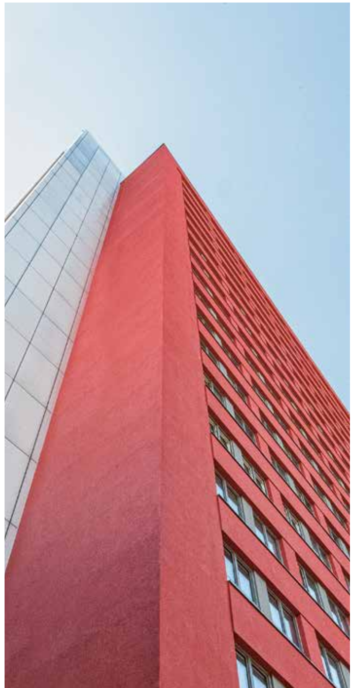
Stefan Forster Architekten, Lyoner Straße 03, Frankfurt/Main 2019, Foto: Lisa Farkas
