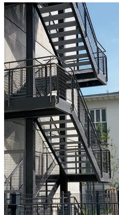
Abb. 19 Südliches Fluchttreppenhaus, nach den Geländerertüchtigungsmaßnahmen, 2017
