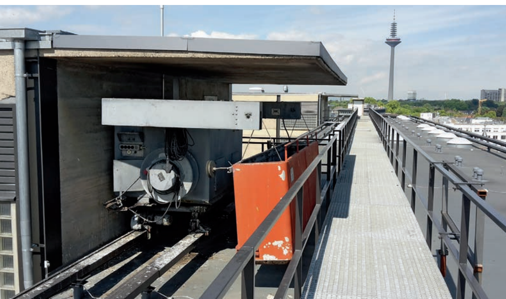
Abb. 26 Fassadenbefahranlage, nach Abschluss der Sanierungsarbeiten, 201
