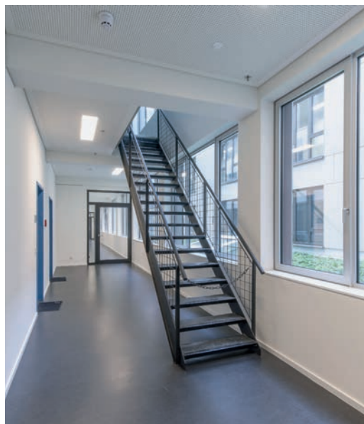
Abb. 21 Erstes Obergeschoss, ehemalige, seminarinterne Treppe, nach Abschluss der Restaurierung, 2018
