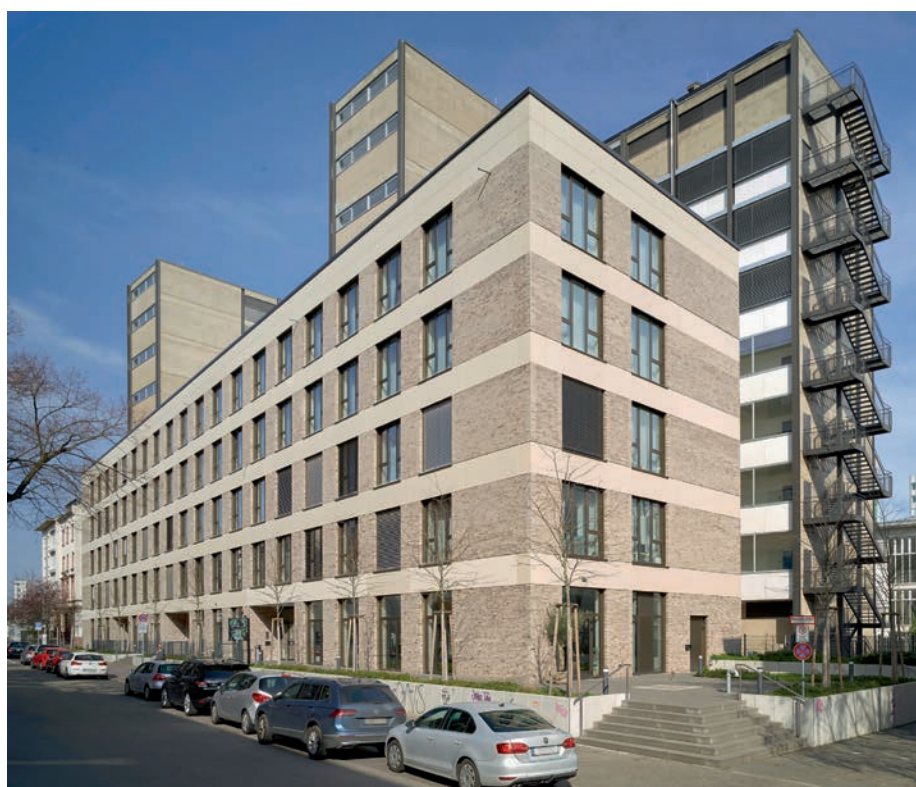
Abb. 12 Philosophicum, mit straßenbegleitendem Erweiterungsbau, Südwestansicht, 2020
