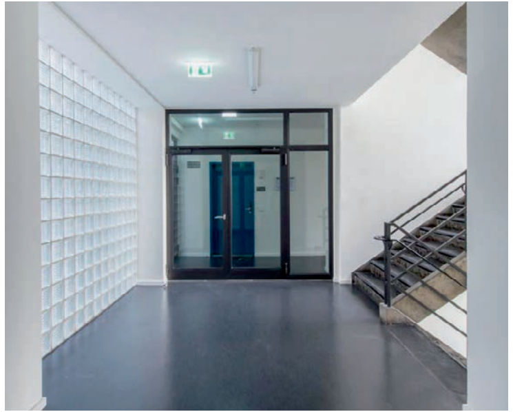
Abb. 25 Regelgeschoss, Brandschutztür entsprechend Brandschutzkonzept, 2018
