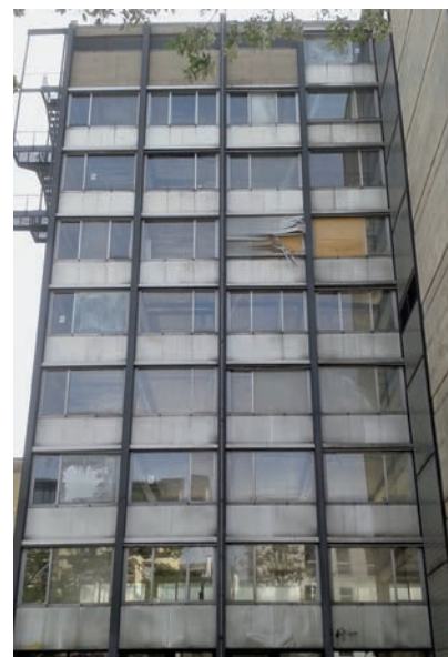
Abb. 8 Westansicht des nördlichen Gebäudeteils, Fluchttreppe, Vorzustand, 2015
