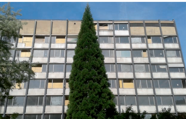
Abb. 15 Ostfassade, Nordabschnitt, vor der Sanierung, 2015
