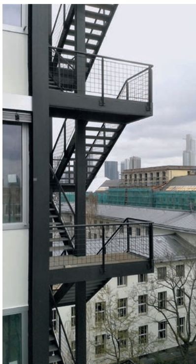
Abb. 18 Südliches Fluchttreppenhaus, vor den Geländerertüchtigungsmaßnahmen, 2016
