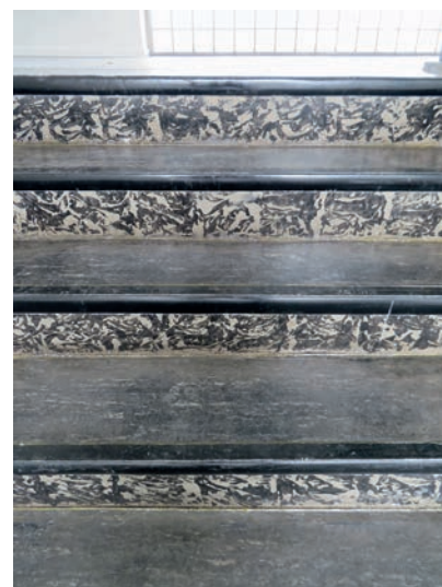
Abb. 6 Treppenstufen mit originaler, gemalter Marmorierung und bauzeitlichem Bodenbelag, 2017
