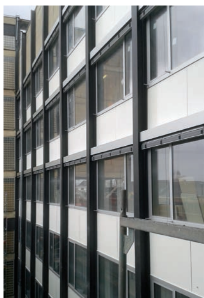
Abb. 11 Westfassade, Außenjalousien im rekonstruierten Zustand, 2016
