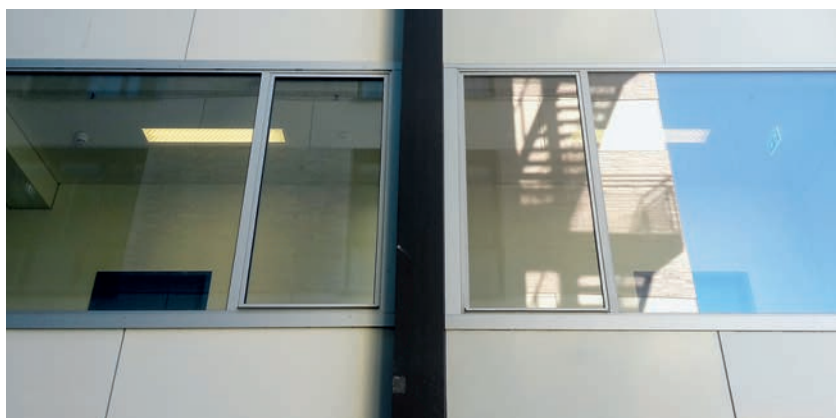
Abb. 23 Südflügel, erstes Obergeschoss, Fenster und Brüstung, rechts der Originalbestand, 2017
