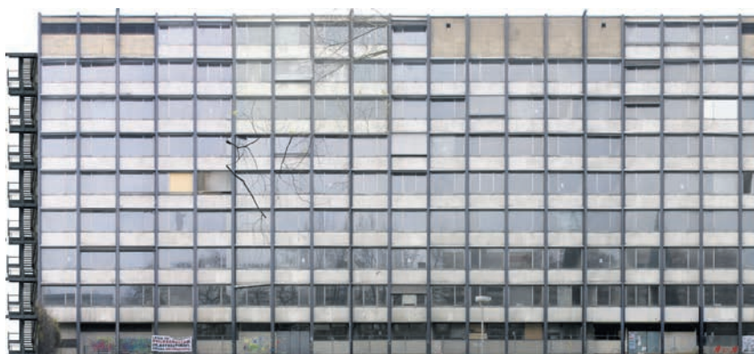
Abb. 2 Ostansicht, photogrammetrische Aufnahme, Vorzustand, 2015
