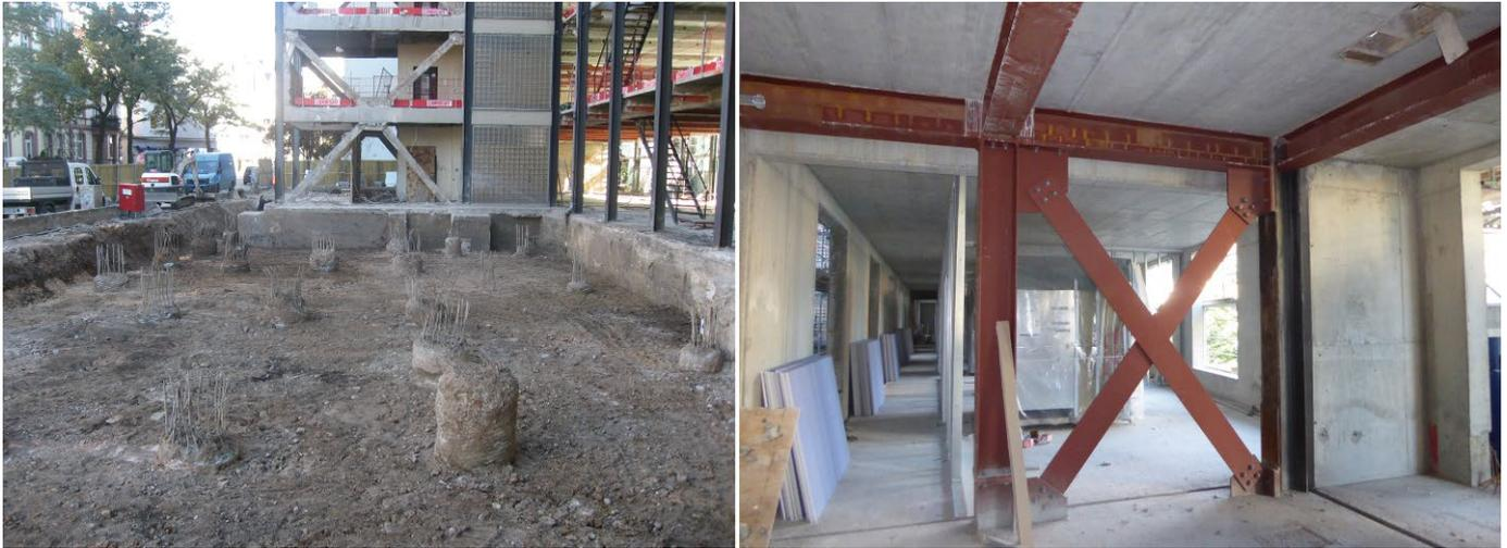
**Bild 9** Vorhandenes Aussteifungssystem, im Vordergrund die neue Pfahlgründung (li.); neues Aussteifungssystem: deutlich erkennbar die umlaufende Fuge zwischen Alt- und Neubau (re.)
