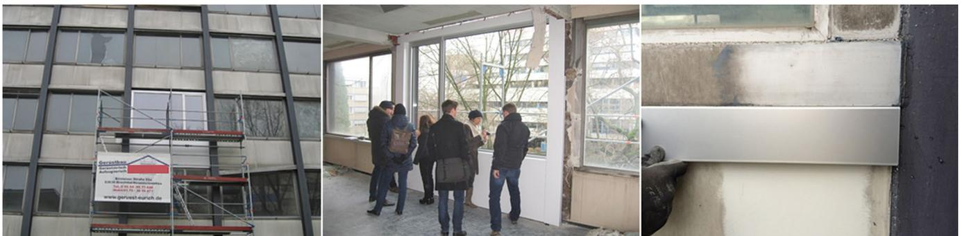
**Bild 6** Rekonstruktion: Musterelement von außen (li.), innen (Mitte), Farbabgleich (re.)
