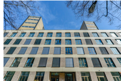
Fassade des Neubaus mit den dahinter liegenden alten Treppentürmen: Insgesamt wurden 238 sogenannte Mikroapartments untergebracht Bild: Lisa Farkas, Frankfurt am Main
