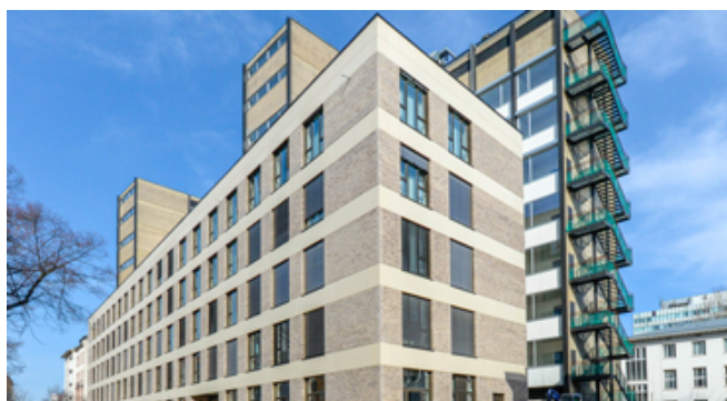
Straßenfront mit dem Ergänzungsbau © Lisa Farkas
