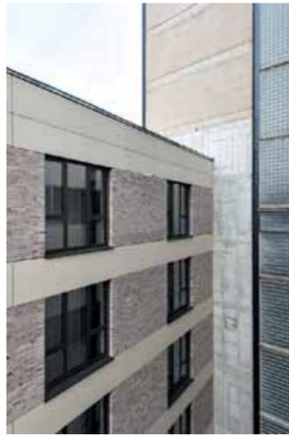
Die Ostfassade sieht fast aus wie vorher (kleines Bild rechts), ist aber komplett neu. Auch die Fensteraufteilung (Kramer brach die Symmetrie mit mal zwei-, mal dreigeteilten Fenstern) wurde nachgebaut.
