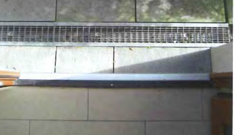
Zugang Garten (Aufsicht) Foto: EM
