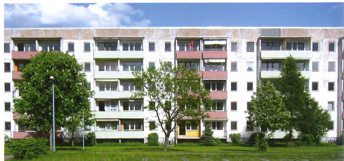
Bestand vor der Modernisierung Foto: Jean-Luc Valentin, Frankfurt am Main
