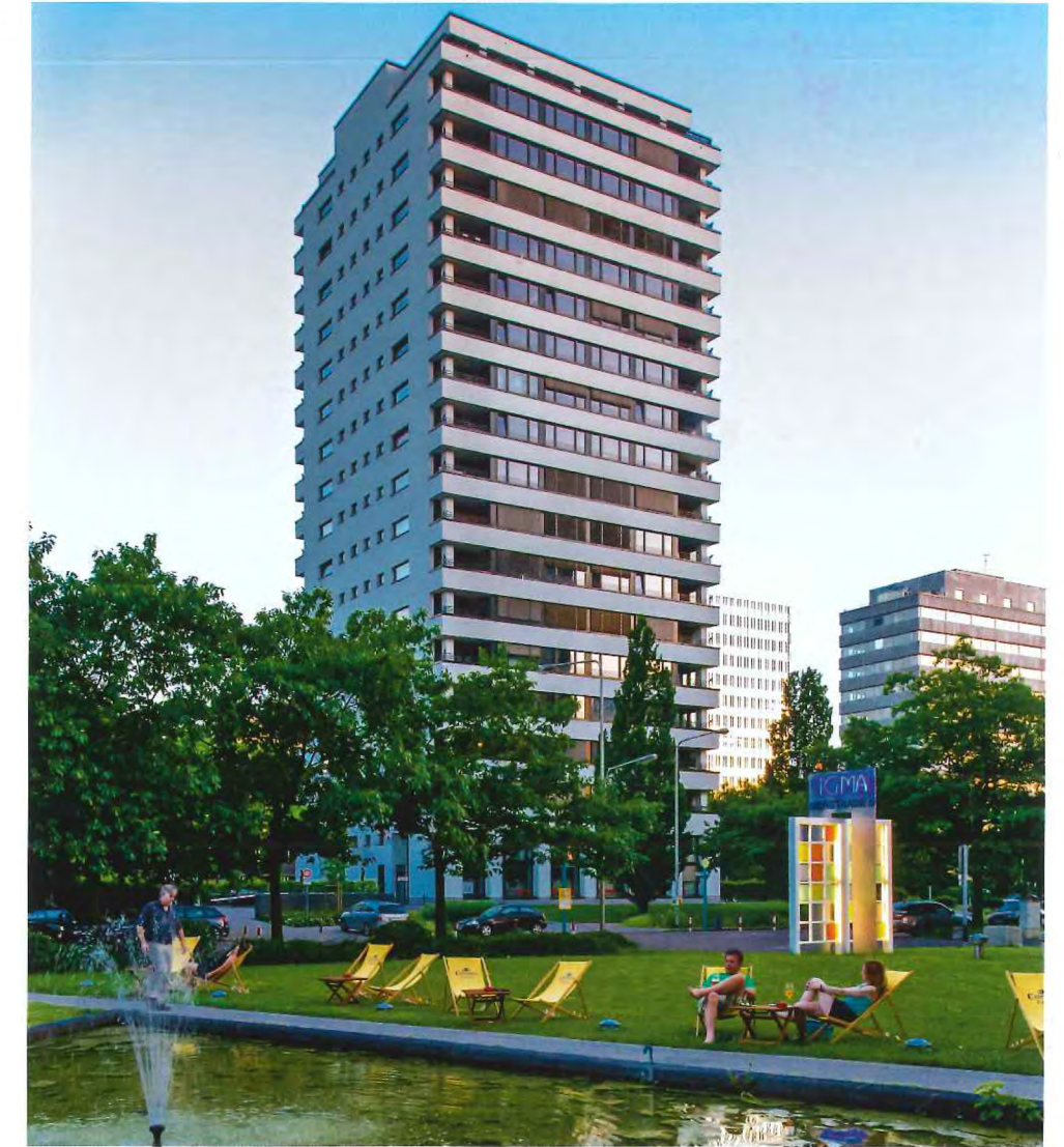
Abb. 5.53: Ostfassade (Quelle: Lisa Farkas, Frankfurt a. M.)
