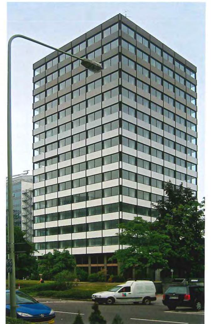
Abb. 5.41: Hochhaus im Bestand (Quelle: dk real estate)
