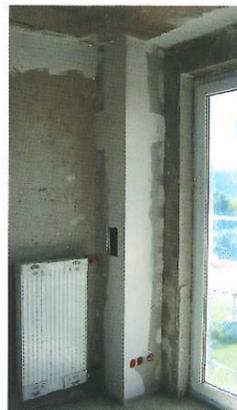
Oben: Die Brüstungen der Balkone wurden an innenliegenden Stahlträgern rückverankert. Die Träger wurden anschließend mit Trockenbauplatten verkleidet
