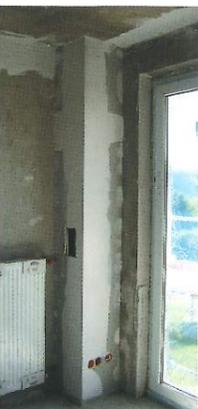
oben: Die Brüstungen der Balkone wurden an innenliegenden Stahlträgern rückverankert. Die Träger wurden anschließend mit Trockenbauplatten verkleidet
