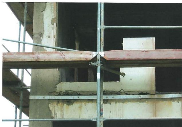
Von oben links: Am Haken – die Plattenelemente wurden an den Fugen freigeschnitten und dann am Montageeisen mit dem Kran abtransportiert. Das Treppenhaus-Loch auf dem Flachdach erhielt später eine Plexiglastkuppel
