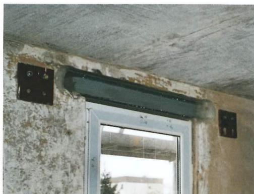
Der Abriss der Zwischenkerne hatte an den Plattenstößen der Fassade wegen der Überlappung zur Innenwand, die nach dem Rückbau zur Außenwand geworden war, zu einer Kerbe geführt. Also schalteten die Handwerker sämtliche Gedäubecken ein und stellten mit Ortbeton einen Wandabschluss her, der den folgenden Gewerken saubere Arbeit ermöglichte.
