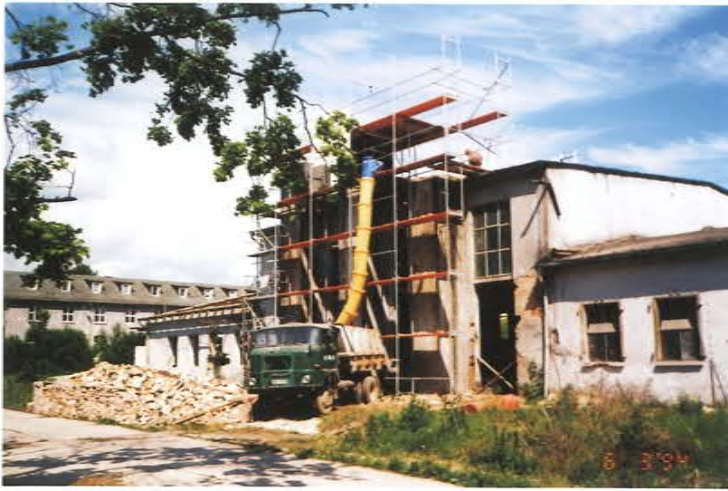
Abb. 218 Abbruch des ehemaligen Heizhauses in Rudolstadt-Schaala zur Vorbereitung der Revitalisierung und Umnutzung des ehemaligen Kasernenstandortes, 1995.
