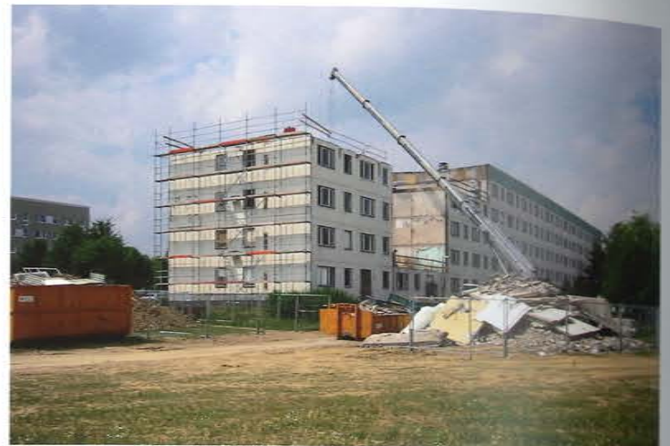
Abb. 212 Leinefelde 2: Umbau. Stefan Forster Architekten, Juni 2003.
