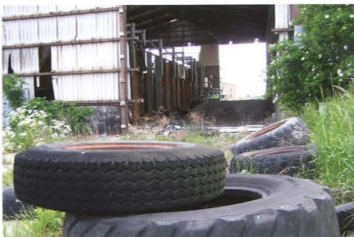
Abb. 217 Ein brachgefallener und „liegen gelassener“ Gewerbebetrieb aus den frühen 1990er-Jahren 2007.
