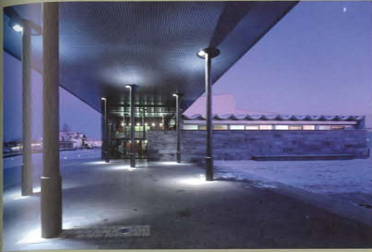
Abb. 208 Die Oberreichsfeldhalle wurde saniert und bildet heute den kulturellen Mittelpunkt der Stadt Leinefelde, 1999.
