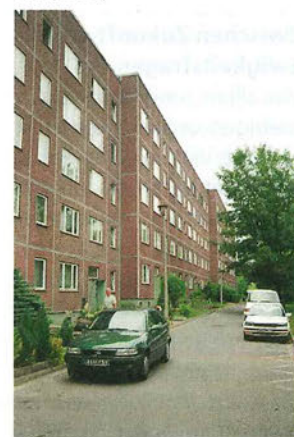
Eingangsseite nach dem Umbau (links); Eingangsseite vor dem Umbau (unten)
