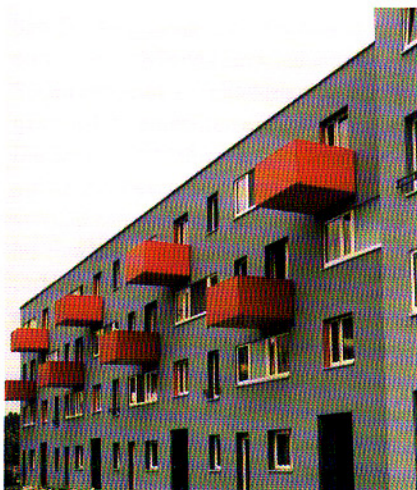
Plattenbauumbau, Leinefelde, im Bau (Copyright: Stefan Forster, Frankfurt am Main)
