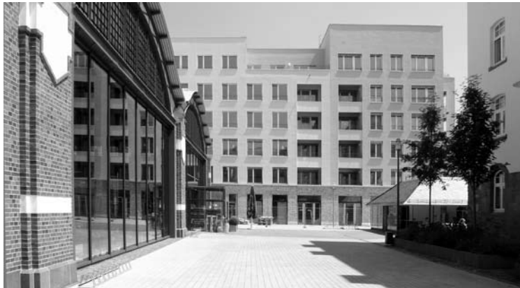
Abb. 4,5: Frankfurt a.M.: innerstädtisches Passivhausprojekt „Campo“.
