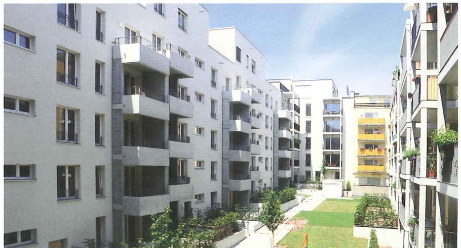
Die Fassaden wurden als hoch wärmegeämmte Holzständerfassaden mit unterschiedlich gestalteten Wärmedämmverbundsystemen ausgeführt
