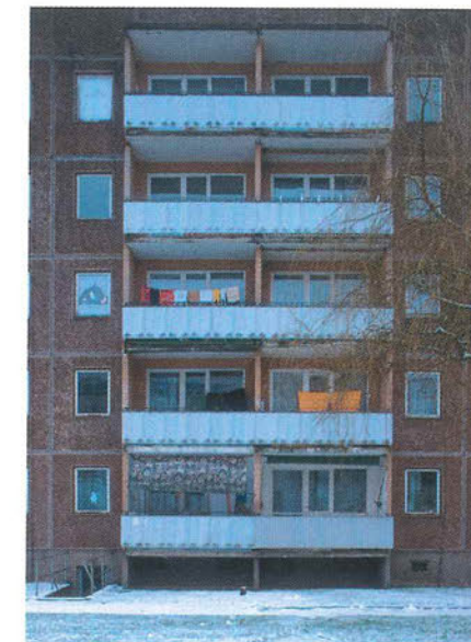
Durchlaufende Balkone, transparente Brüstungen und vergrößerte Fenster bestimmen jetzt die Fassade
