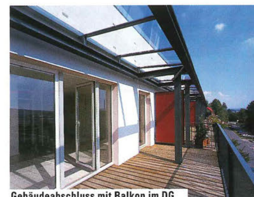
Gebäudeabschluss mit Balkon im DG
