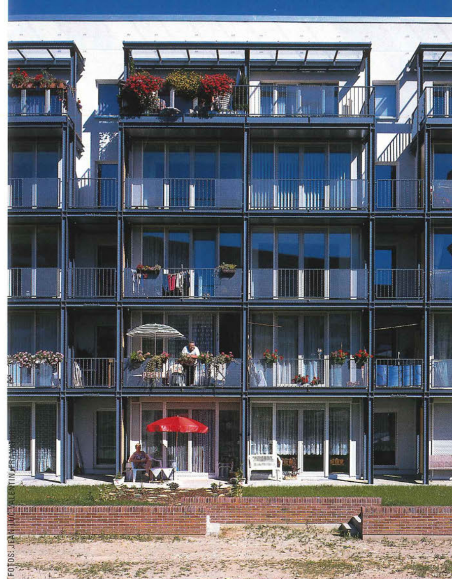
Durchlaufende Balkone, transparente Brüstungen und vergrößerte Fenster bestimmen jetzt die Fassade
