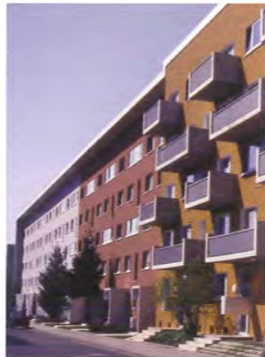
Planungsgebiet Hertz-/ Einstein-/Hahnstraße: Ein vorkragendes Dach fasst die Gebäuderiegel mit einer großen Geste zusammen.
