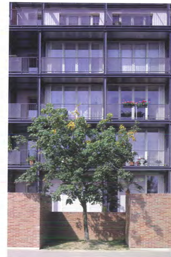
Planungsgebiet Lessing-/ Büchnerstraße: Die hohen Backsteinmauern der „grünen Zimmer“ schaffen nicht nur einen Sichtschutz, sondern auch eine neue Gartenzone für die Zeilen. Die übrigen Wohnungen erhielten Balkone.
