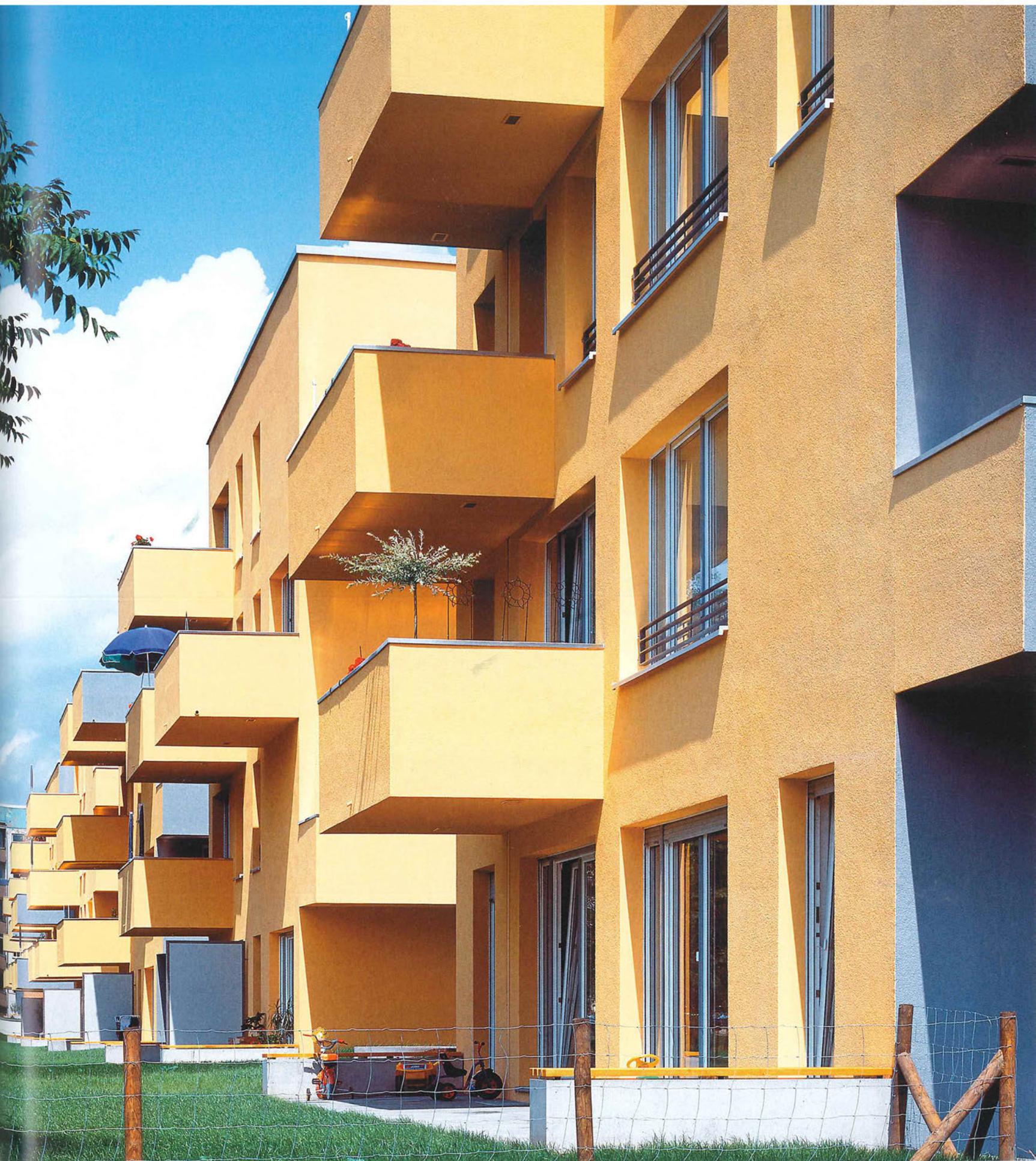
Die Fassade und die in Stahlbeton ausgeführten Balkone wurden wärmegeklämmt und mit einer durchgängigen Putzstruktur überzogen.
