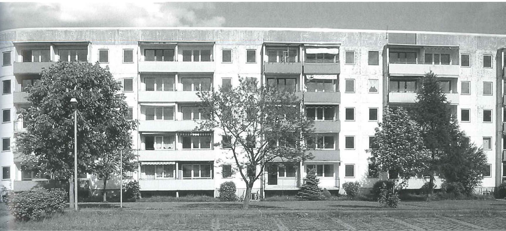
Der Plattenbau in der Westansicht vor dem Rückbau: Die 200 Meter lange Zeile wird durch den Entwurf in acht Einzelgebäude transformiert.
