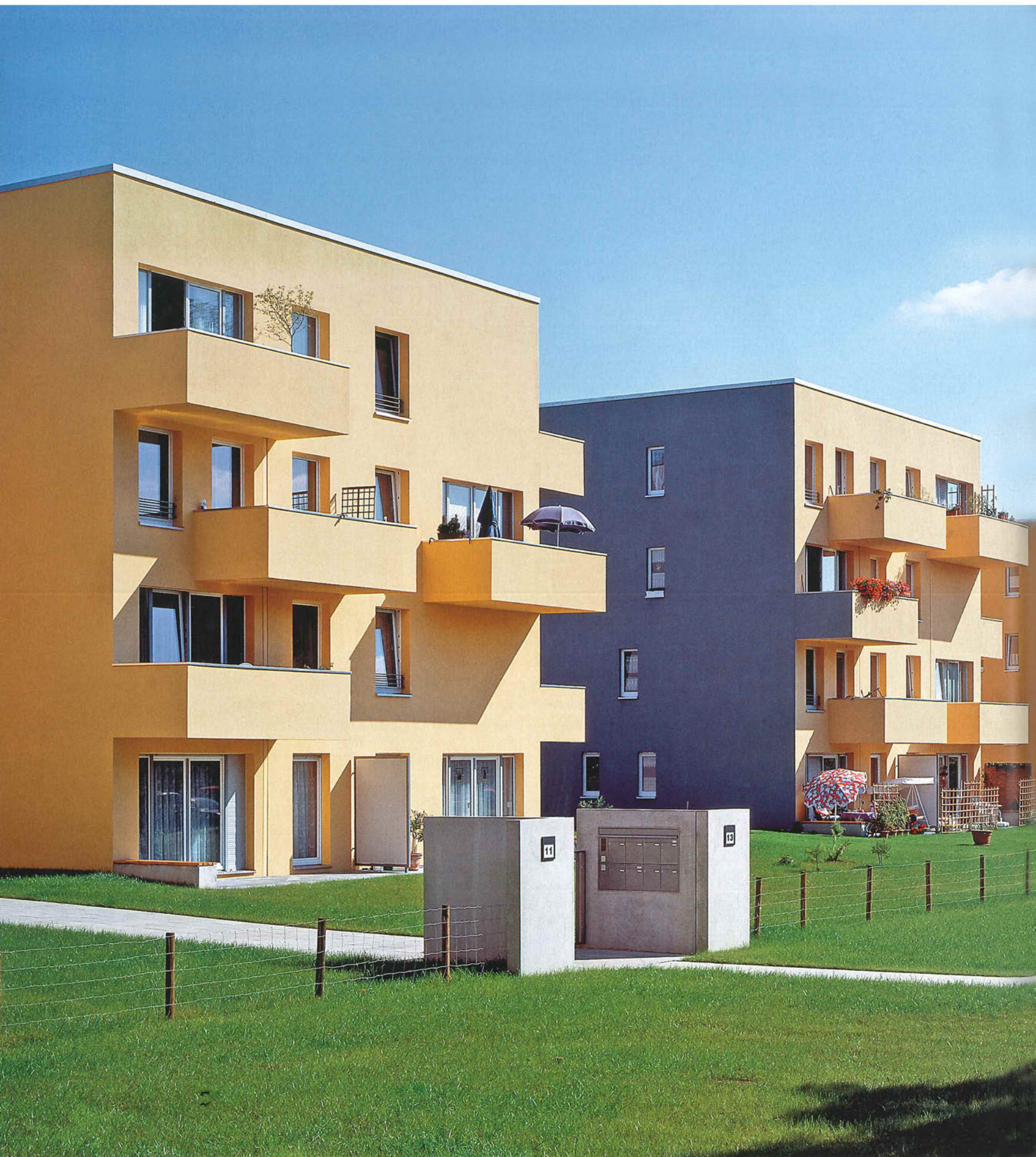
Die zum Garten gewandte Westseite wirkt auf Grund des gelben Anstriches und der differenzierten Anordnung der Balkone sehr lebendig.
