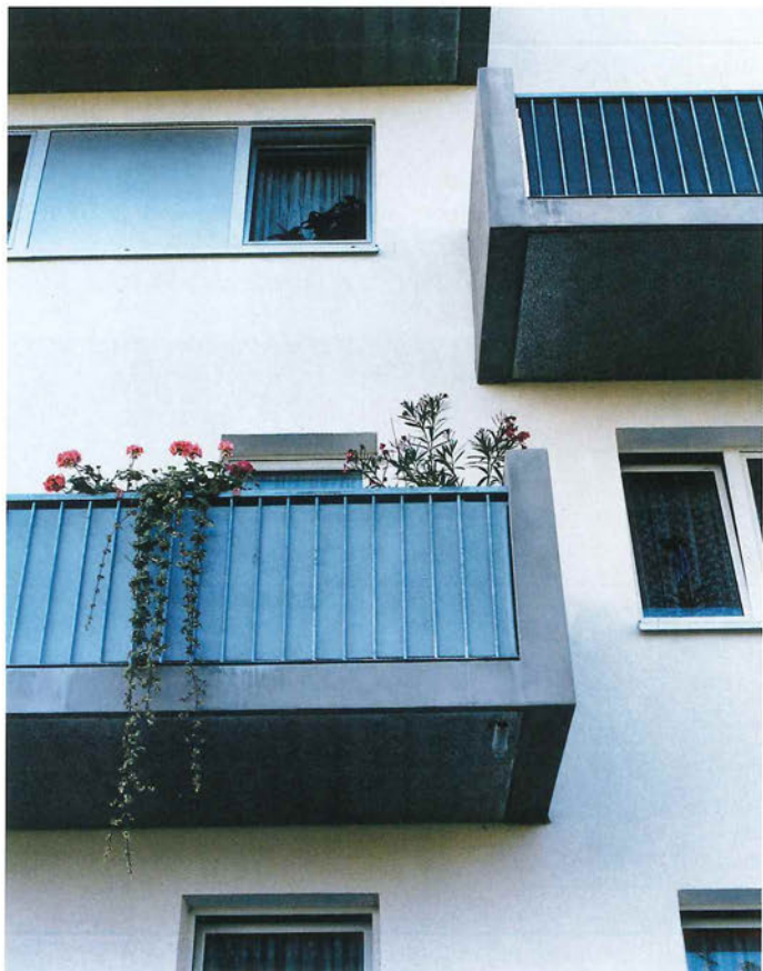
Balkone in Petzets Wohnhof: massiver Zuwachs an Wohnraum – und an Fassadenplastik
