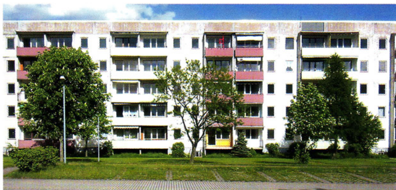
Vor dem Eingriff des Architekten: 150 Wohnungen waren in dem 180 Meter langen und fünf Etagen hohen Gebäuderiegel untergebracht
