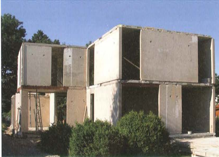
Dem Rohbau aus Recyclingmaterial sieht man seine Herkunft noch an.
