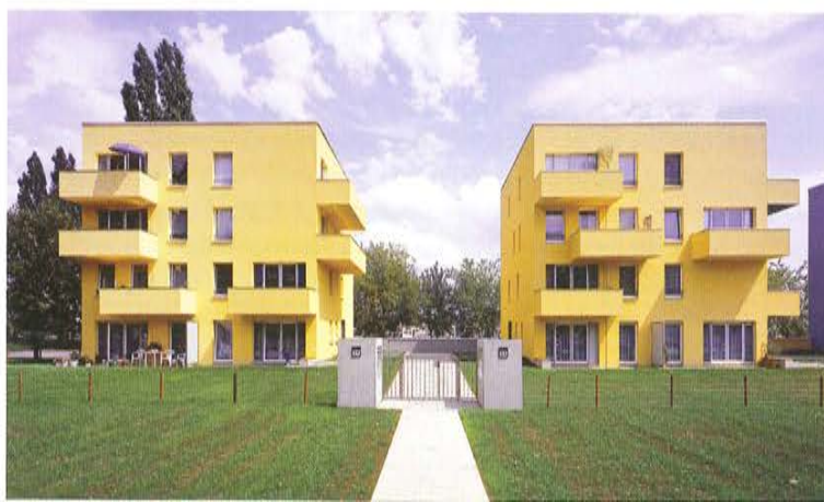
Balkone schieben sich aus den Fassaden und stellen den Bezug zum Außenraum her.
