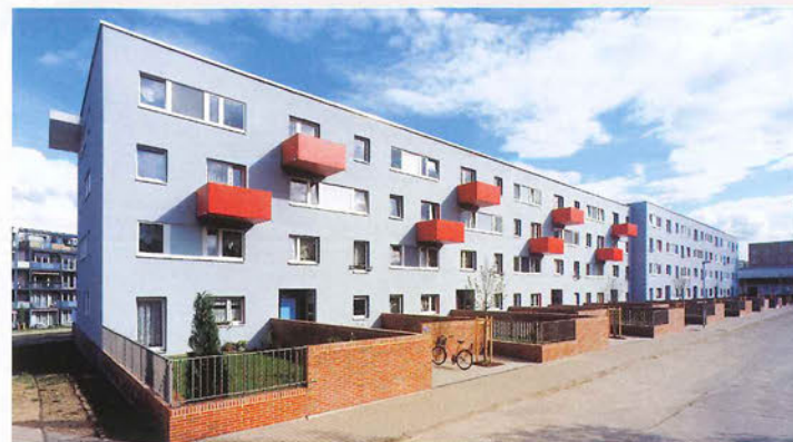
links: Buchnerstraße Expo 2000, Leinefelde, Rückbau von zwei Geschossen, Umbau von 64 Plattenbauwohnungen Bauherrenpreis 2001 rechts: Rück-/Umbau von Plattenwohnungen, Leinefelde, 2003
