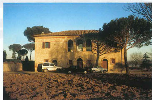
Sanierung einer Villa nahe Siena, Eingangsseite, 1986
