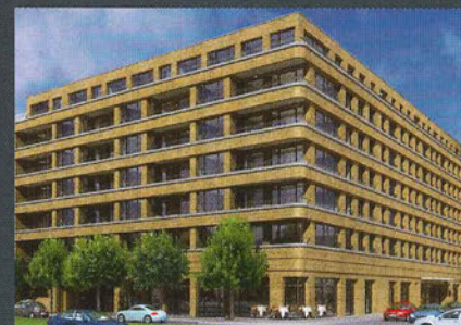
Westgarten, 2. Bauabschnitt, Frankfurt am Main
