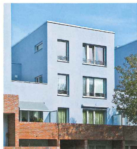
Sonderpreis CO 2 -optimiertes Bauen: Umbau von Plattenbauten (Stefan Forster, Frankfurt/M.)
