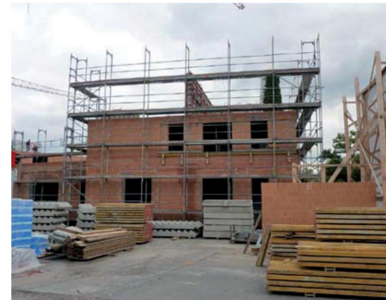
Mit einem Schalldämm-Maß von 49dB bei einer Wandstärke von 36,5cm bei gleichzeitigem Wärmeleitwert von  $\lambda = 0,13 \text{ W/(mK)}$  ist der TS13 optimal auf die Anforderungen im Geschosswohnungsba abgestimmt.
