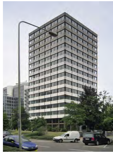
Der Büroturm vor dem Umbau
