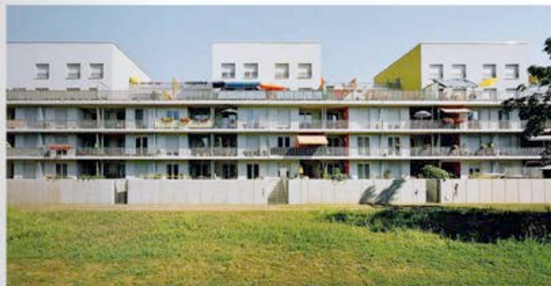
Kaum zu erkennen, aber dieses Gebäude ist das gleiche wie auf dem Bild des Bestandes. Mit Rückbau, farblicher Überarbeitung und neuen Vorbauten wie Balkonen und Gärten wirkt die Anlage modern und einladend.
