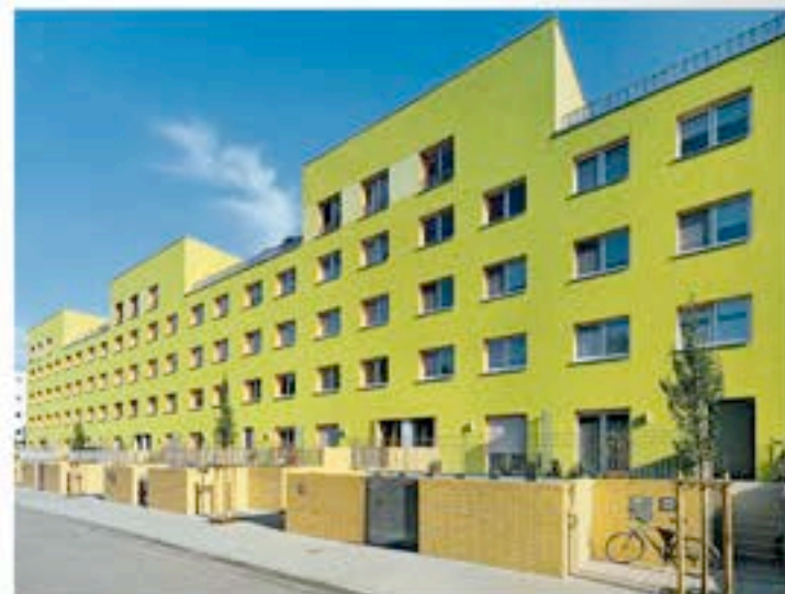
Die Nordfassade ist im Gegensatz zur Südfassade in einem hellen Grün gestrichen und verleiht dem Komplex eine gewisse Frische.
