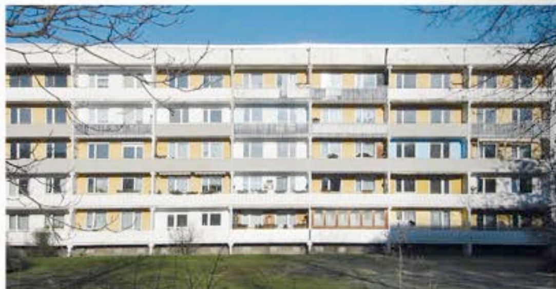
Der ursprüngliche Bestand der Anlage am Oleanderweg verprügte den typischen Charme eines Plattenbaus. Darin Potenzial zu erkennen, erfordert ein geschultes Auge.
