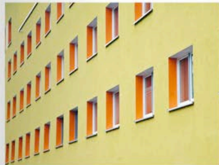
Die östlichen Seiten der Fensterlaibungen wurden in einem kräftigen Orange gestaltet, während die übrige Laibungen in einem hellen Grau gestrichen wurden.
