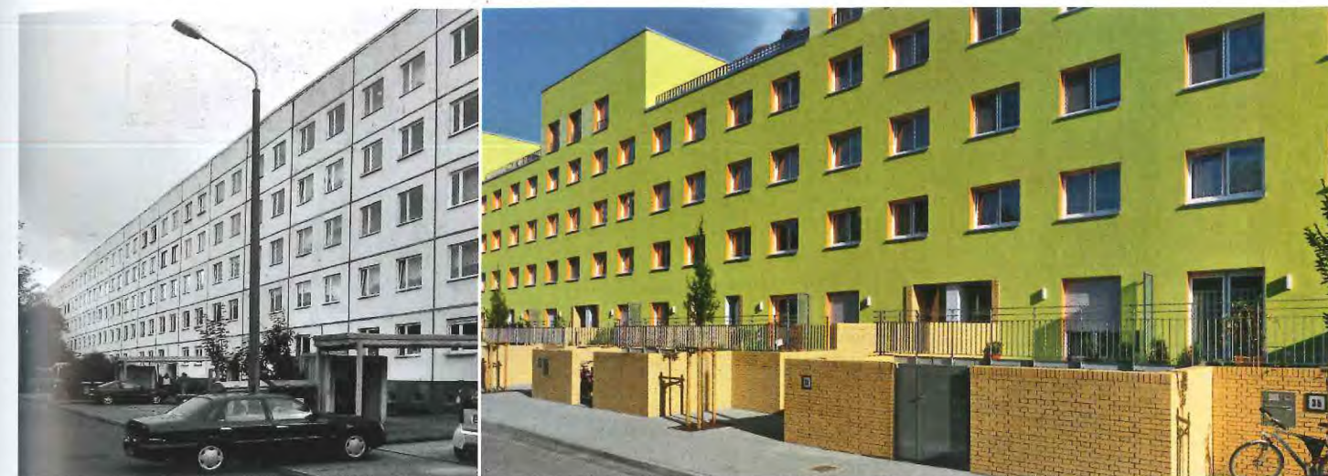
Oleanderweg/Halle: Der Plattenbauumbau entstand im Rahmen der IBA Stadttumbau 2010. Das Projekt hat das Büro Stefan Forster Architekten realisiert. 81 Wohneinheiten wurden rückgebaut, die Dachwohnungen durch Dachterrassen aufgewertet. Bild links: vor Sanierung, Bild rechts: nach Sanierung
