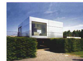
34. Haus der Gegenwart Allmann Sattler Wappner. Architekten Munich, 2005
