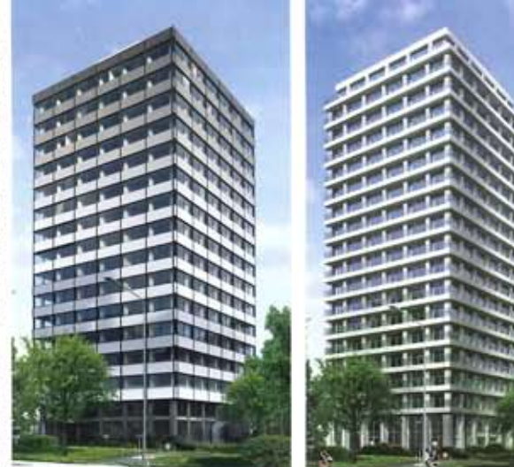
Edificio per uffici a Francoforte (Germania), prima e dopo l'intervento di trasformazione in edificio residenziale, Stefan Forster Architekten Office building in Frankfurt [Germany] before and after the transformation in a residential property, Stefan Forster Architekten
