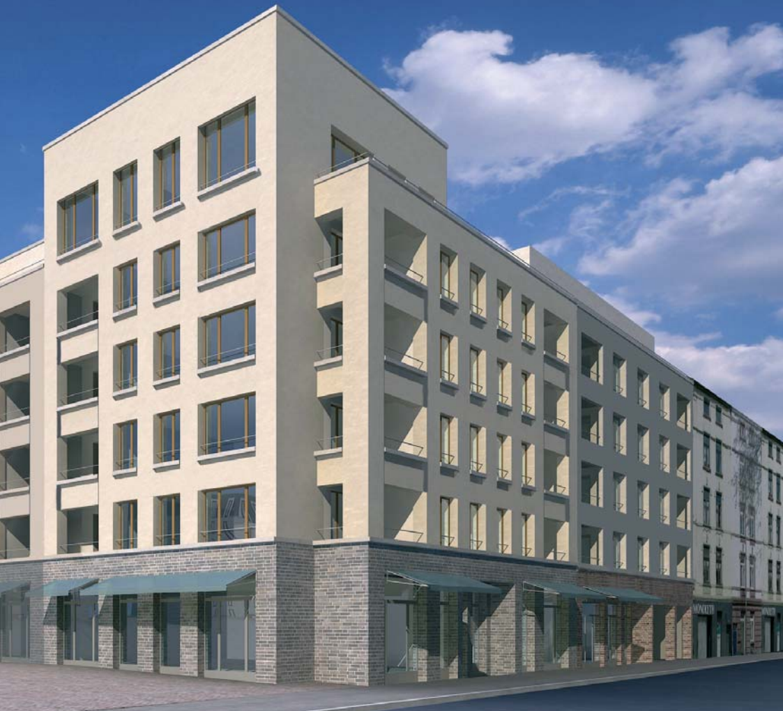
Foto: © Stefan Forster Architekten
