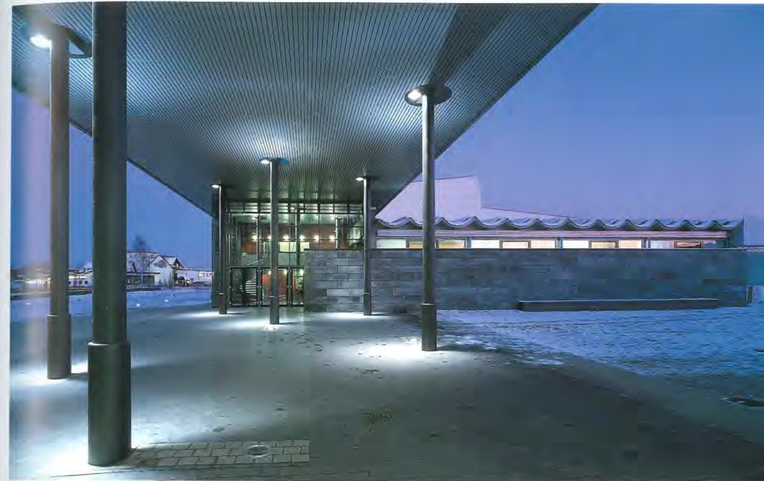
Dach mit 12 Stahlstützen Roof with 12 steel supports
