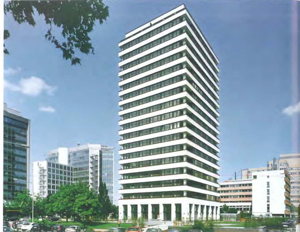
Wohnhochhaus, Zustand nach dem Umbau 2010 Residential highrise, condition after conversion in 2010
