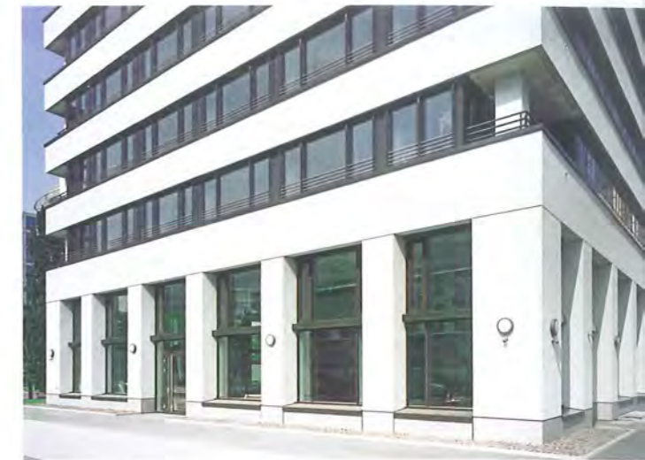
Sockelzone mit betonen Stützen Base zone with accentuated pillars
