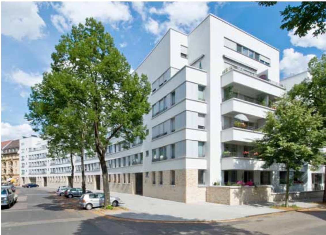
Ersatzneubau „Schwarzwaldblock“, Mannheim, 2007-2015
