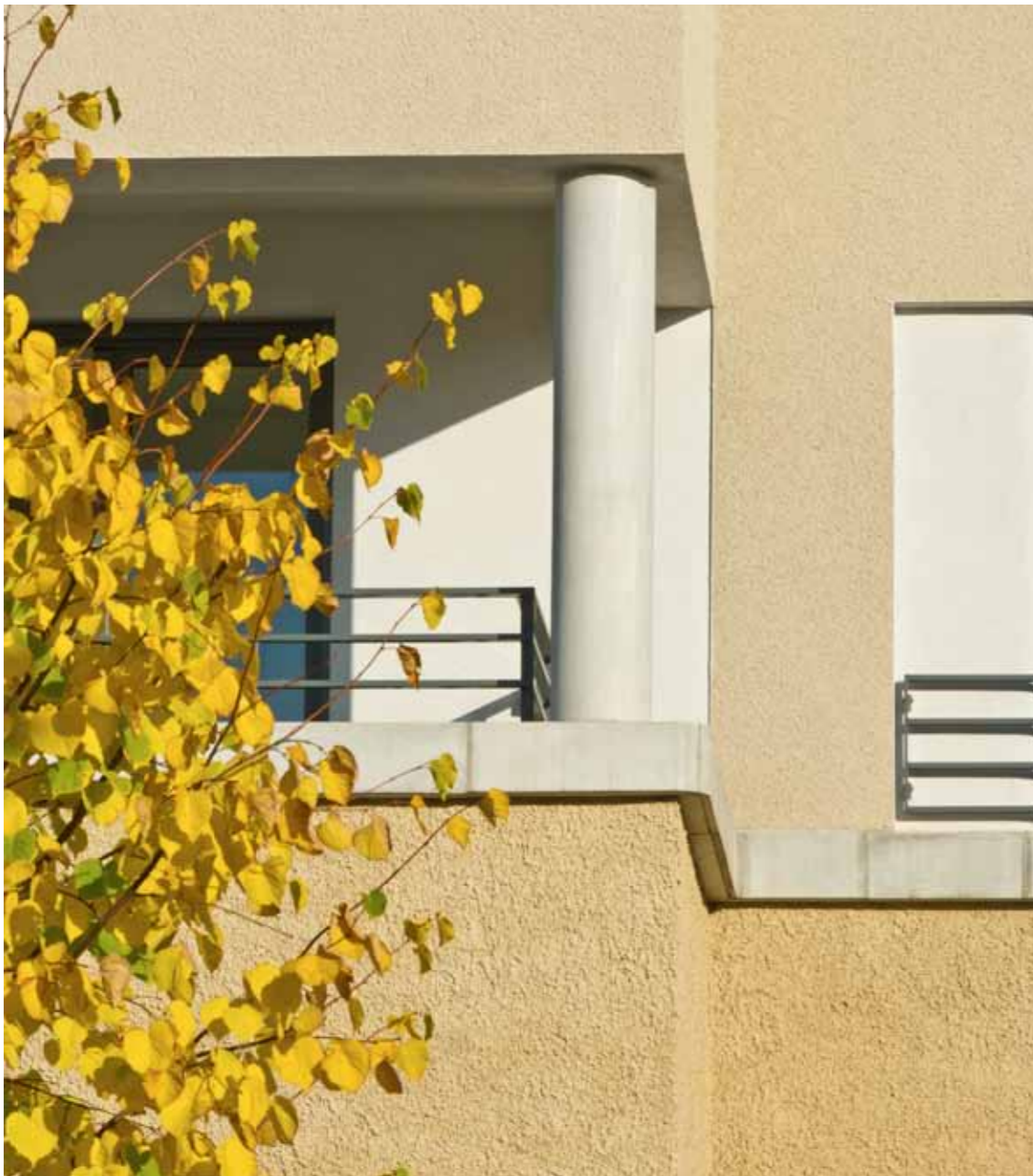
Wohn- und Geschäftshaus „Mörfelder Landstraße“, Frankfurt, 2010
