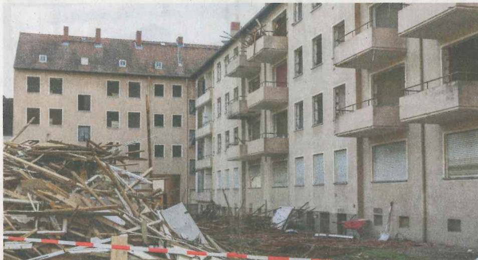
Am Ostkarree geht's voran: Aktuell wird entkernt, nächste Woche kommt die Abrissbirne. Foto: sth
