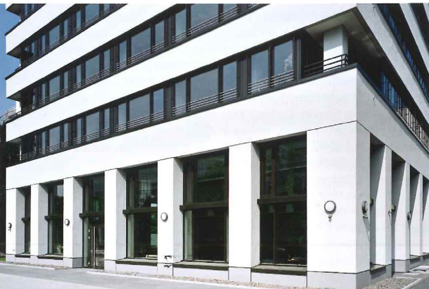
Brüstungen und Pfeiler sind mit weißem Fassadendämmsystem verkleidet.
